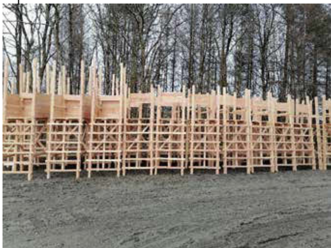
Kombisitze sind mit vorgefertigtem Holz und Schablonen rasch gebaut
